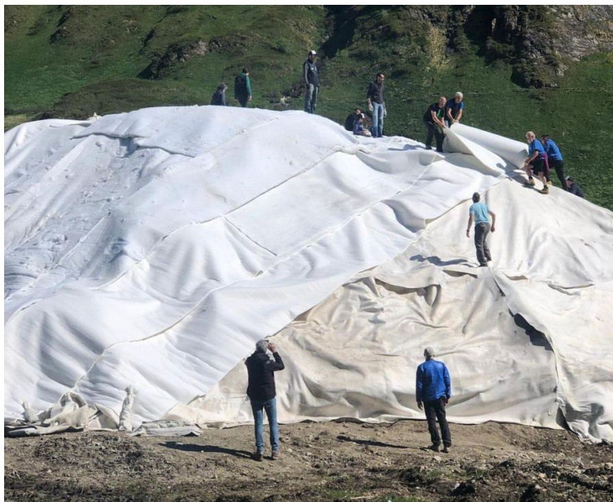
Operai a lavoro a Riale per preservare la neve tramite la tecnica dello snow farming
